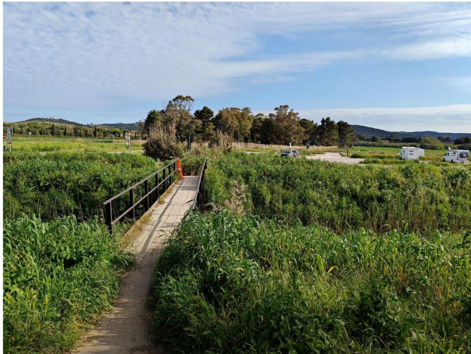
Figura 7.1-3 Ponte sul canale allacciante Cervia
