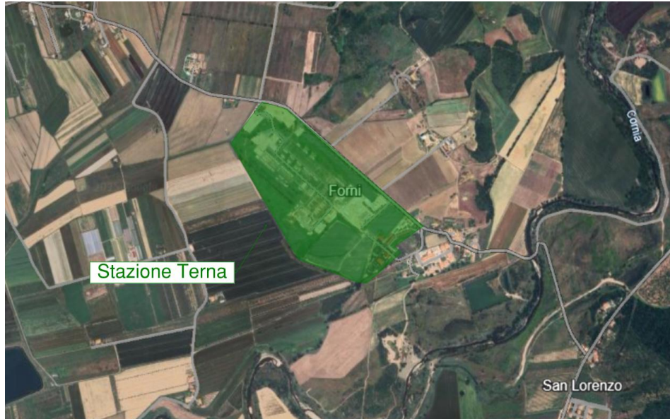
Figura 4.5-1 Panoramica della S.E. denominata “Suvereto”
